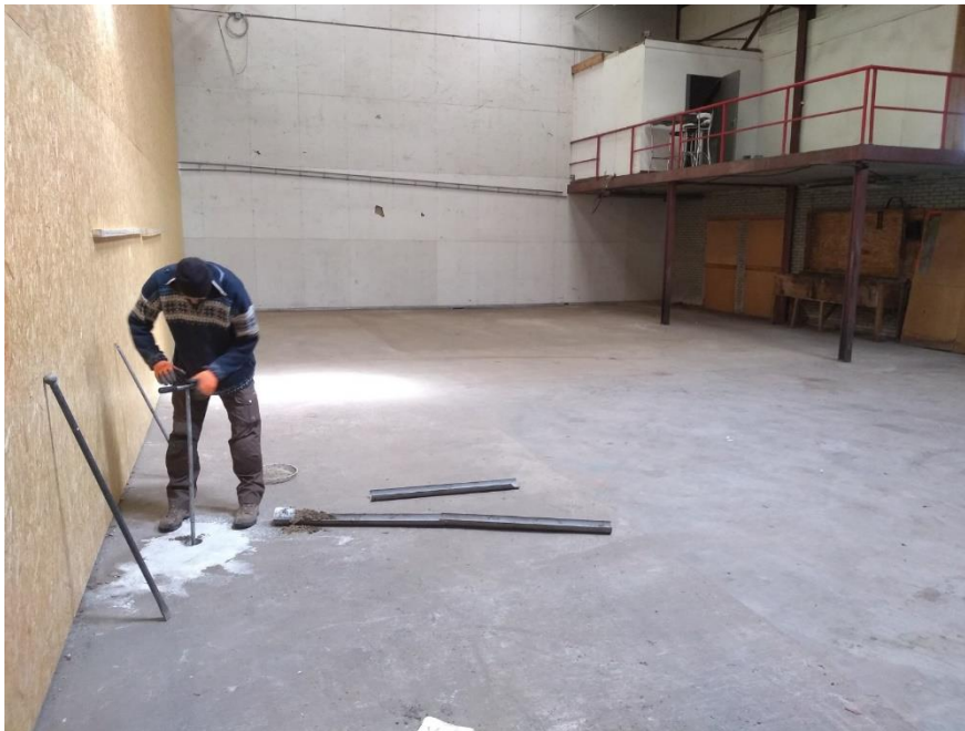
Afbeelding 15: Uitvoering van de inpanidige boring 6. Zie bijlage 3 voor de locatiefoto's.
