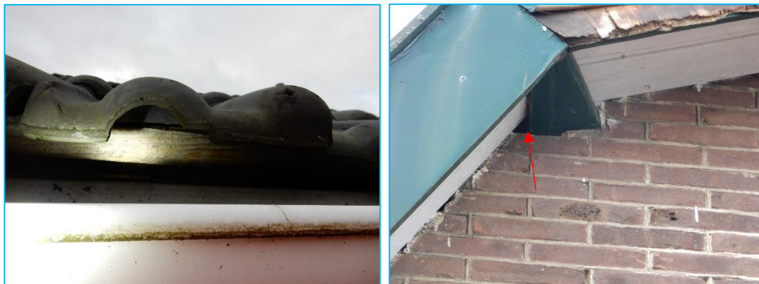
Foto's: Ruimte tussen de dakpannen en het dakbeschot en openingen in de gevel geschikt voor huismus.
