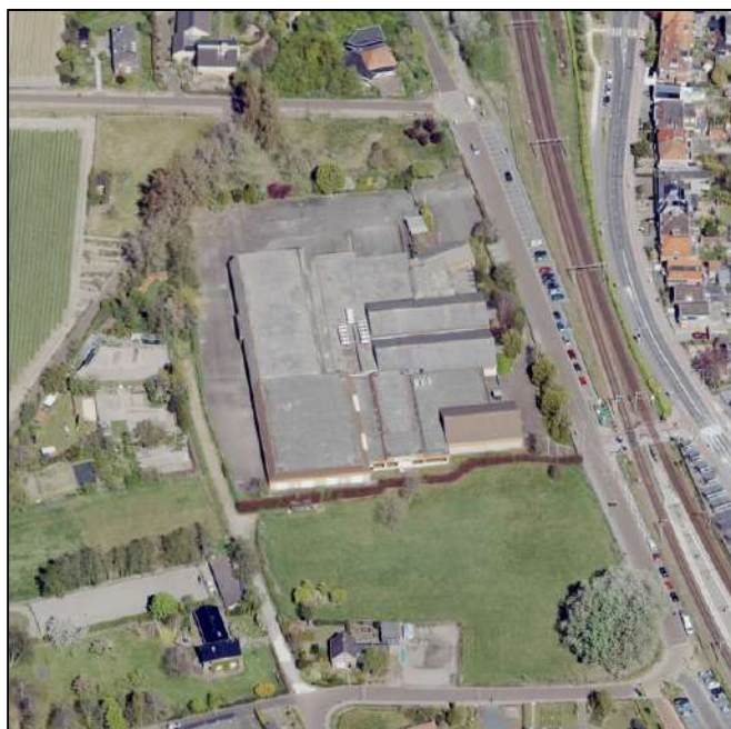
Figuur 2: Luchtfoto bestaande situatie (21-04-2020), Bron: StreetSmart.
