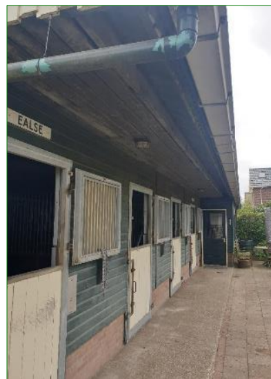
De te slopen paardenstal.
