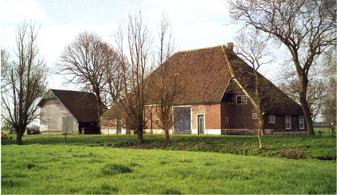
Bestaande situatie (noordoostgevel boerderij)
