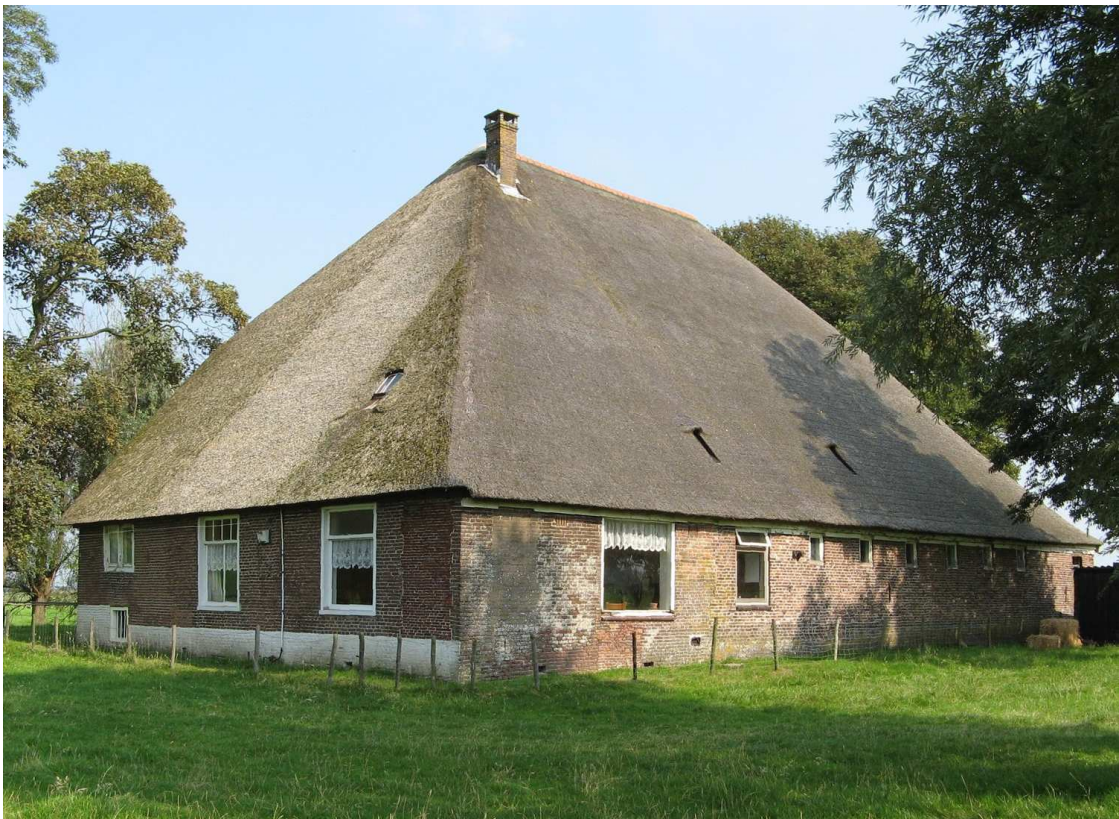
Bestaande situatie (zuidwestzijde boerderij)
