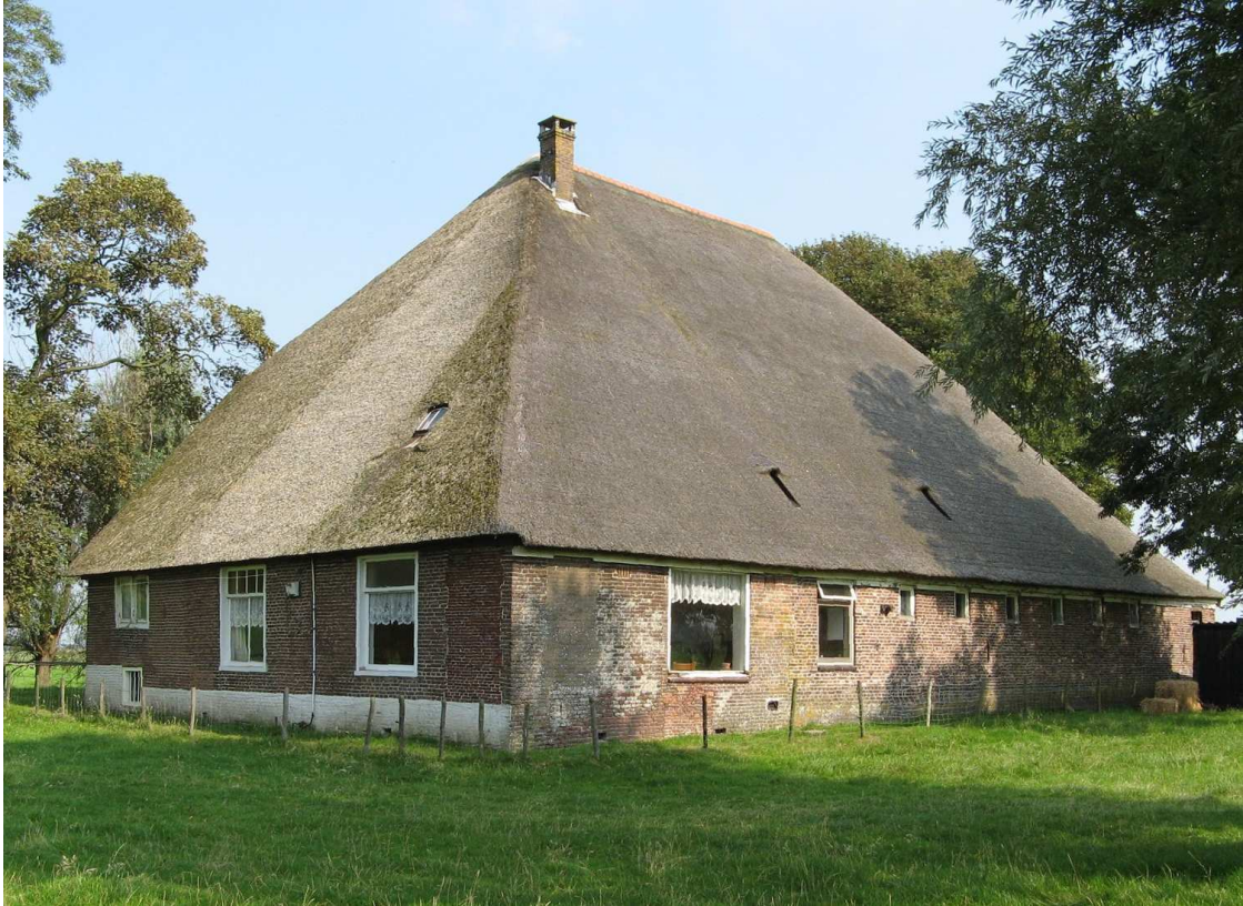
Bestaande situatie (zuidwestzijde boerderij)
