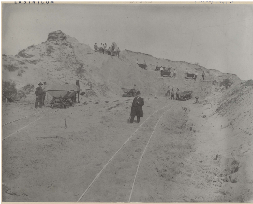
Afbeelding 8. Zandafgravingen ten noorden van de Zanderij in 1904. De afgravingen vonden plaats ten behoeven van de bouw van het gesticht Duin en Bosch. Bron: Beeldbanknoordholland, NL-HlmNHA_559_01285.
