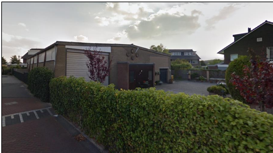
Situatie plangebied voor de sloop van de bebouwing (Bron: Google Streetview).
