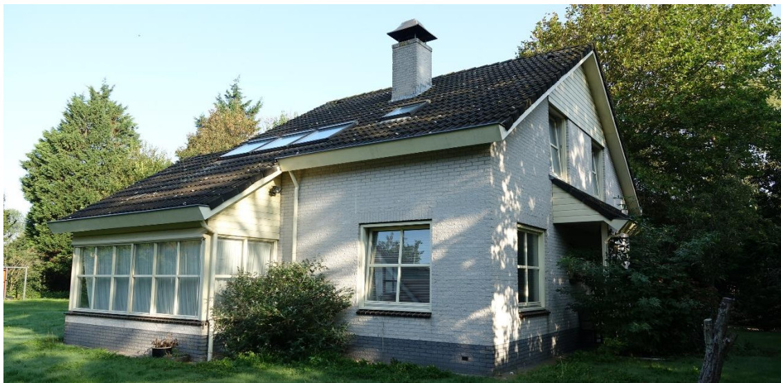
Figuur 6: Voorbeeld van het dak waarop alle dakpannen recht liggen en goed aansluiten.
