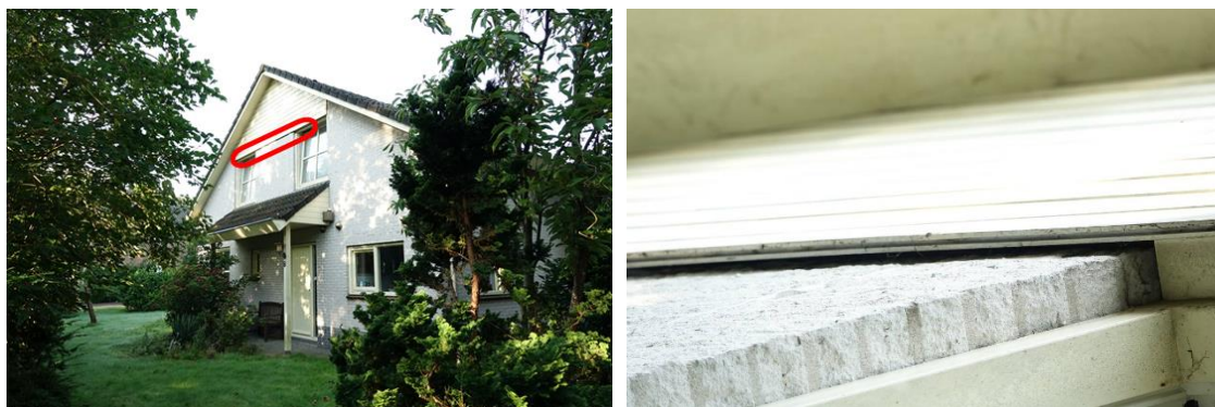
Figuur 8: Geschikte opening voor vleermuizen aan voorgevel tussen gevel en houtwerk binnen het rode kader en close up.
