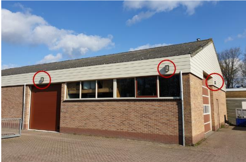
Figuur 4 De aanwezige verlichting aan de bedrijfsruimte zorgt voor lichtverstoring op vleermuizen.
