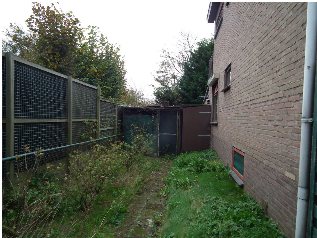
Figuur 4 Bijgebouw en zijgevel van de woning. Het bijgebouw is vrij toegankelijk voor fauna maar heeft geen relevantie als vaste rust- en verblijfplaats door de afwezigheid van schuilmogelijkheden.
