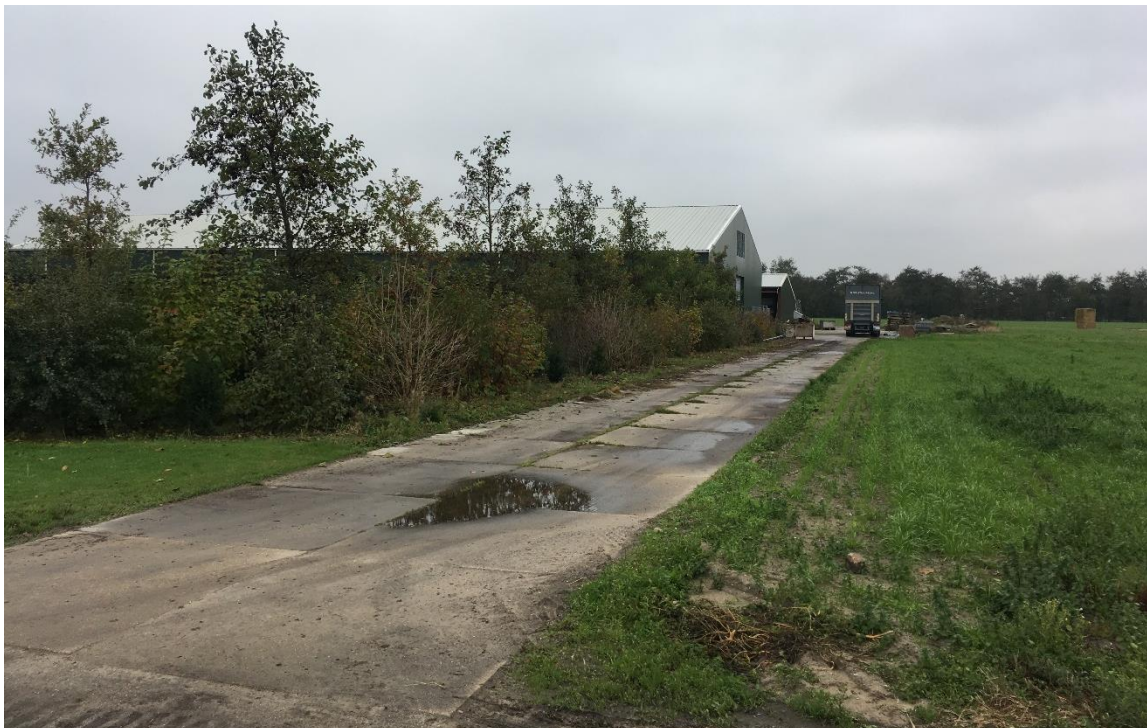
Afbeelding 5: In- en uitrit Limmerweg in de huidige situatie
