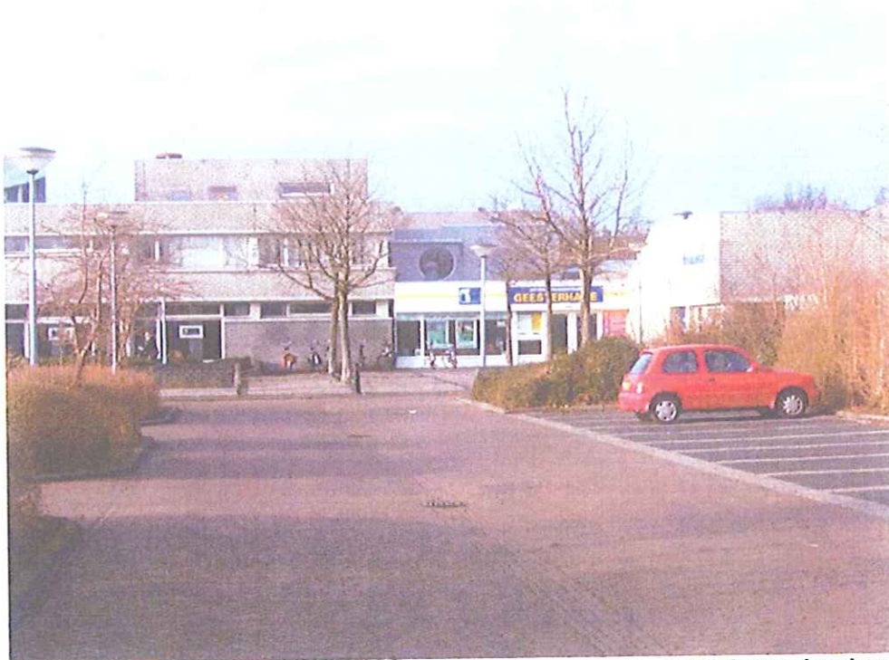
Het multifunctionele gebouw met op de voorgrond een parkeerplaats.
