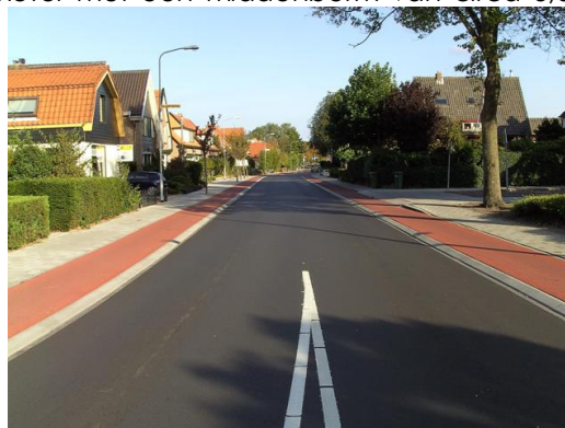
Ruiteweg na de reconstructie (eigen foto)
