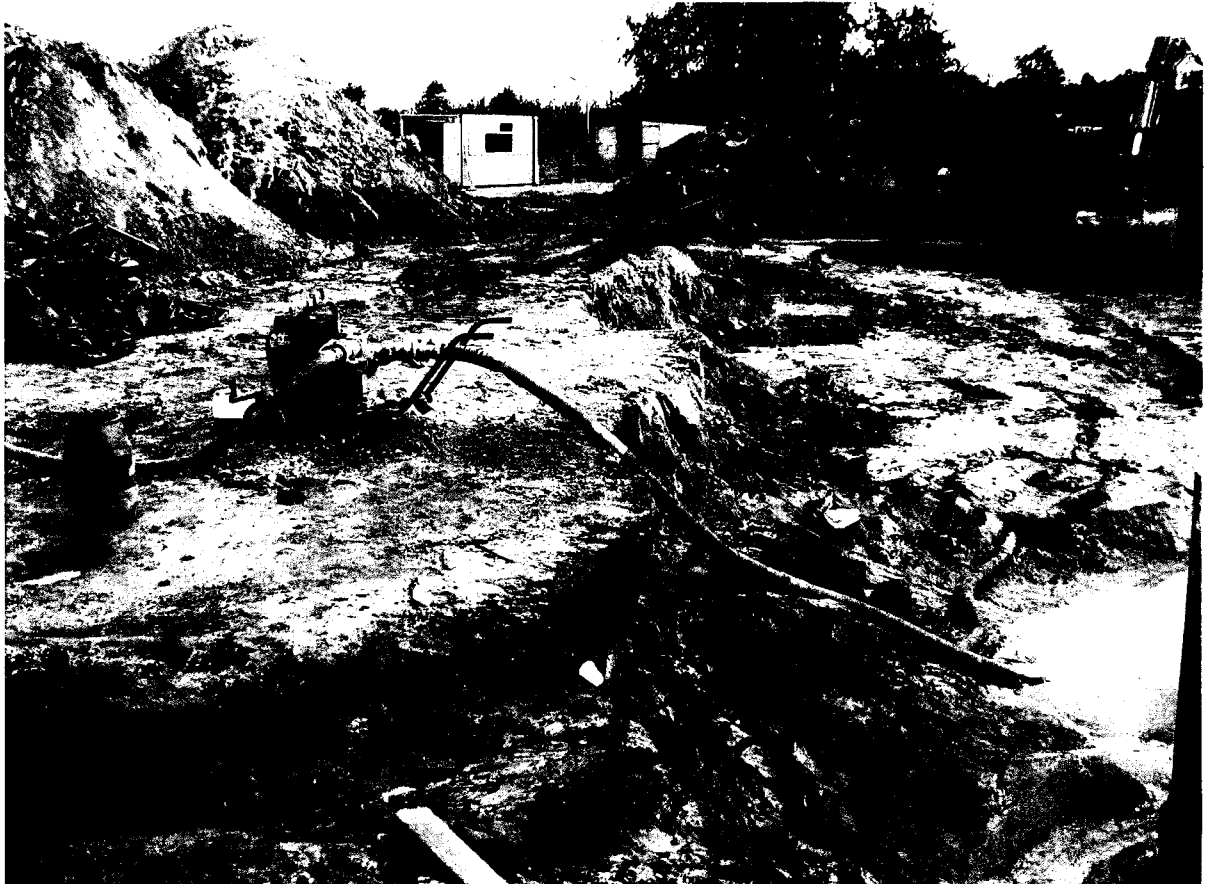
Foto 1: Ontgraving minerale olie verontreiniging
