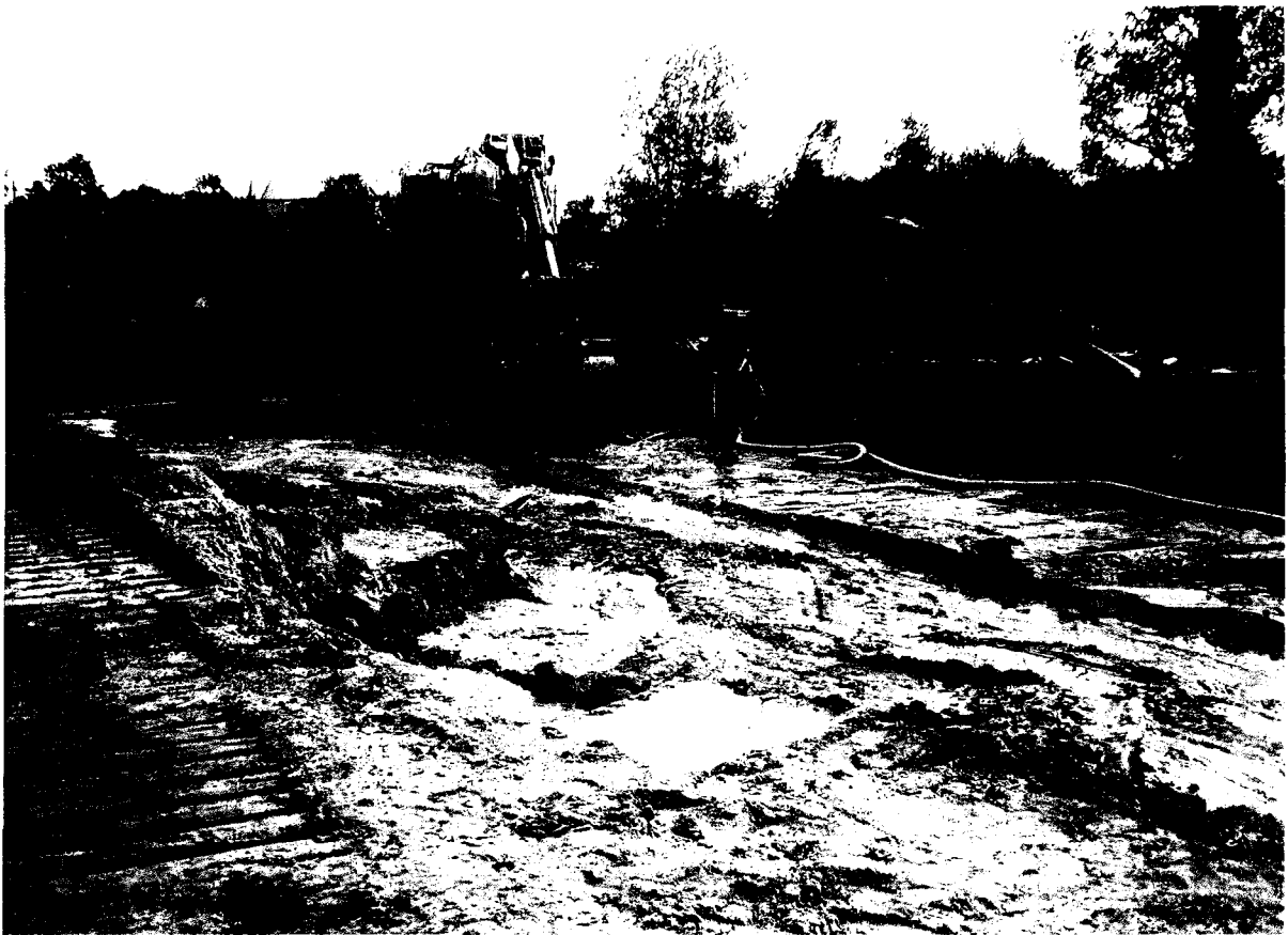
Foto 2: Ontgraving minerale olie verontreiniging
