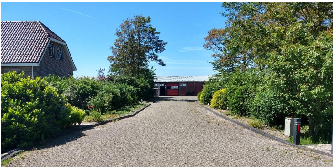
Afbeelding: Weergave van een deel van het perceel Westerweg 36 met op de voorgrond de woning en achterliggende de bijbehorende voormalige bedrijfsbebouwing.
