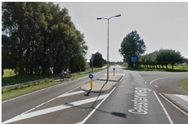
Zicht op oversteekplaats
