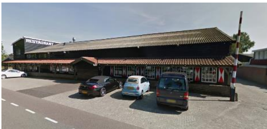
Figuur 2.1: Hoofdgebouw Jachthaven Laamens aan de Geesterweg
