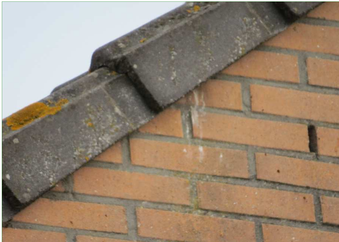
Typische invliegplek (voorbeeldfoto, niet op onderzoeklocatie) van Gierzwaluw onder een eind nokvorst. Aan de hand van sporen op de muur zijn invlieglocaties op te sporen.
