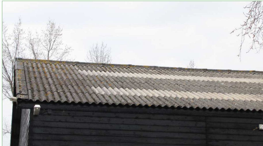
Deel van het golfplaten asbestdak.
