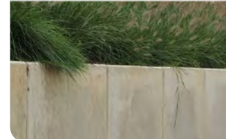
Keermuur, laag: beton
