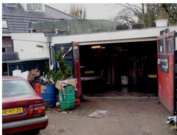
garage aan achterzijde plangebied
