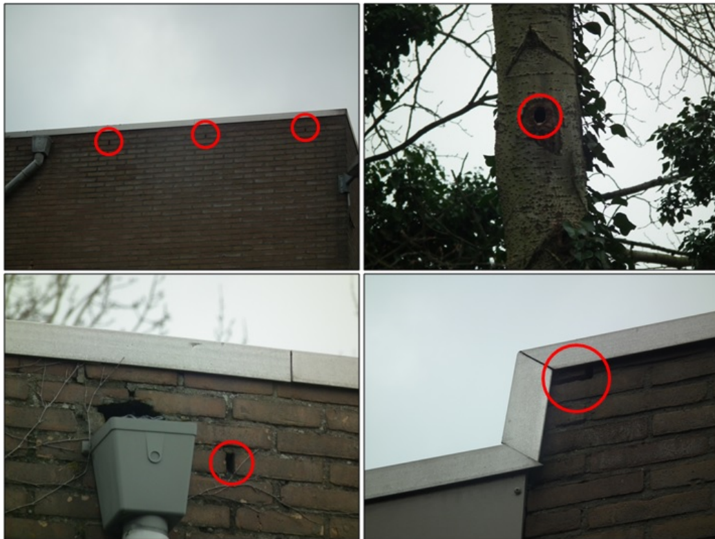
Figuur 2 In het pand en enkele bomen zijn verschillende openingen aangetroffen die mogelijk geschikt zijn als vaste- rust en/of verblijfplaats voor vleermuizen (rood omcirkeld).
