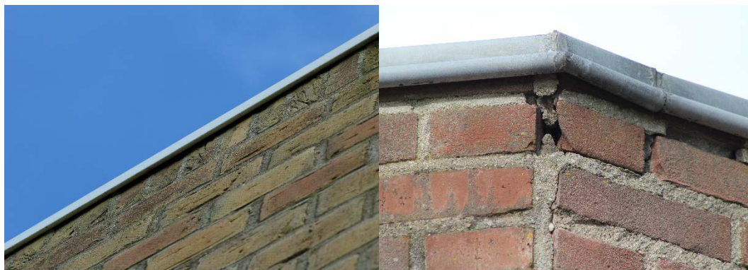
Figuur 3.5 Ruimtes onder daklijsten en openingen door afbrokkeling. Links het dorps huis en rechts de voetbalvereniging
