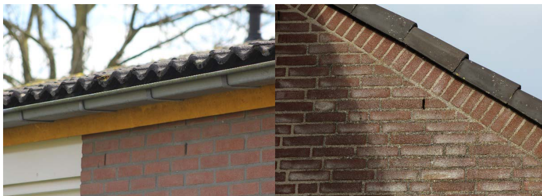
Figuur 3.8 Ruimtes onder dakpannen. Links het schoolgebouw en rechts de gymzaal
