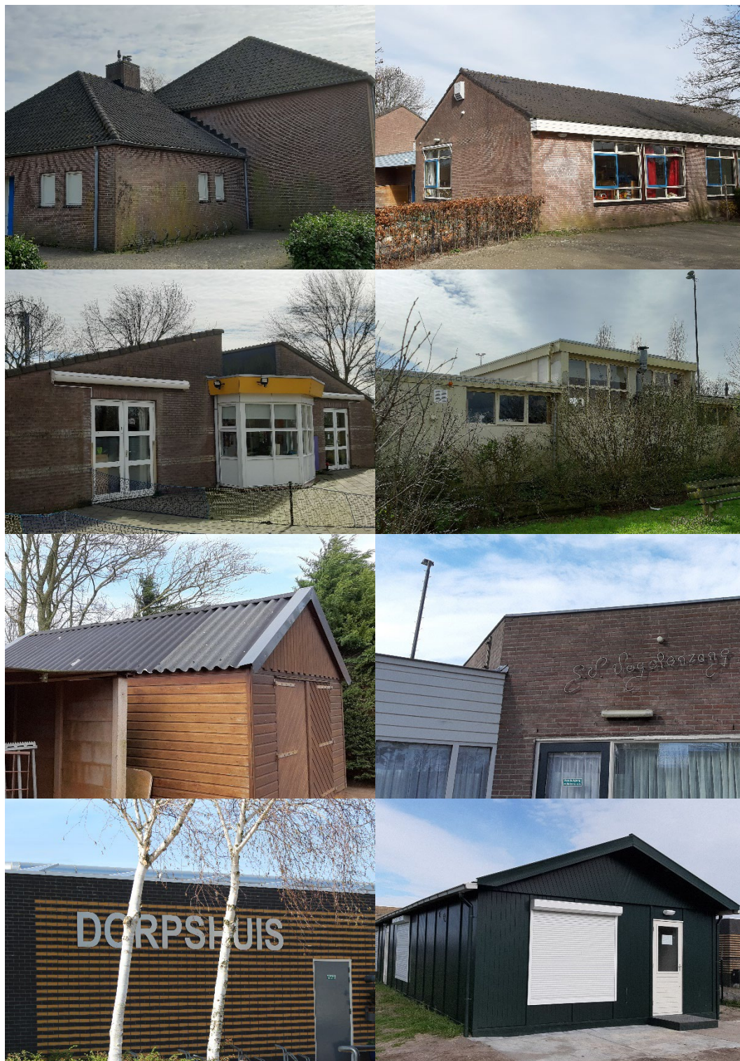
Figuur 2.2 Gebouwen in het plangebied. Van links naar rechts: gymzaal, schoolgebouw, kinderdagopvang, tennisvereniging, schuurtje naast tennisbanen, voetbalvereniging, dorpshuis en jeugdhonk
