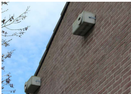
Figuur 3.9 Twee nestkasten voor gierwaluw aan de noordkant van het schoolgebouw
