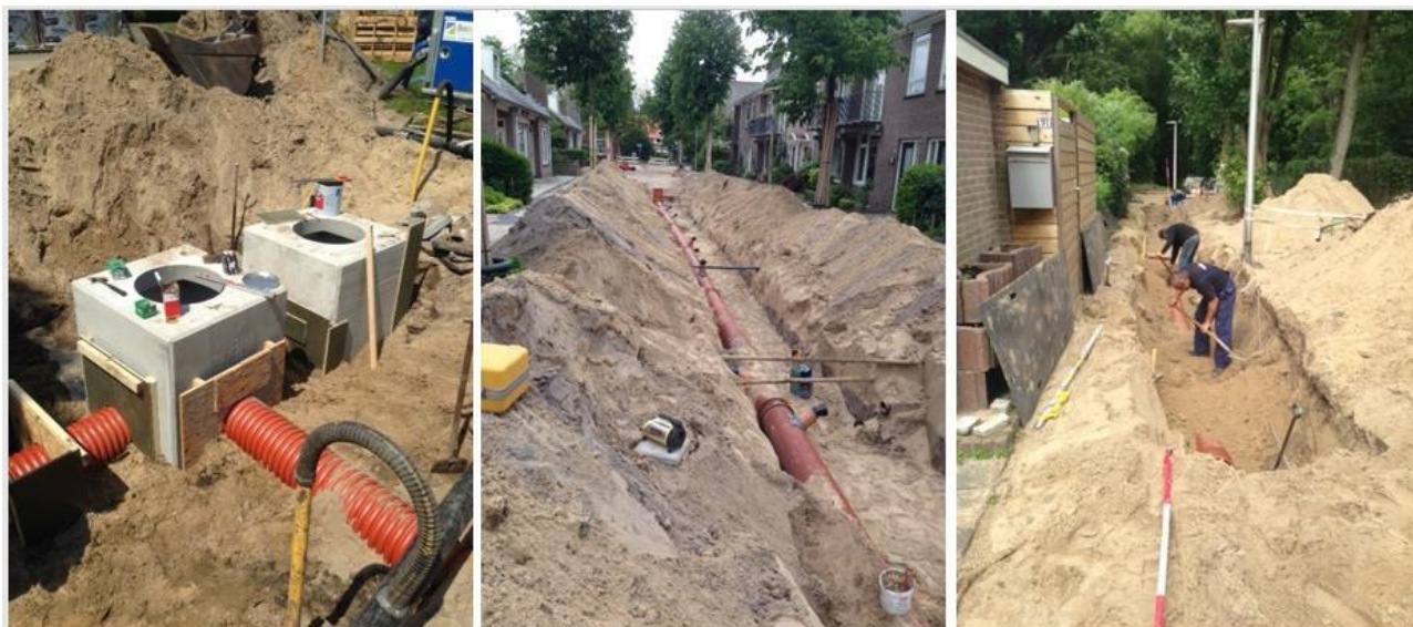
Rioleringswerkzaamheden in Heemstede (Bron: gemeente Heemstede)
