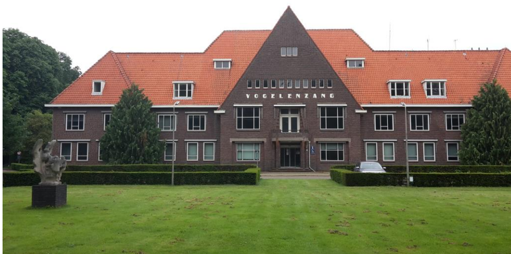
Figuur 1.1 Het monumentale hoofdgebouw Vogelenzang bij de entree van het GGZ InGeest-terrein.
