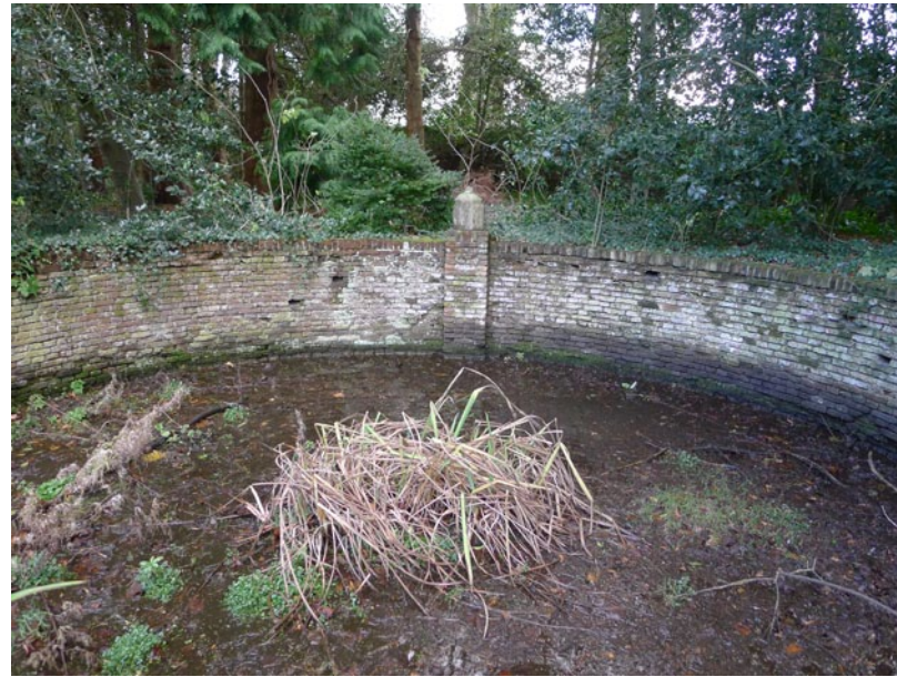
gemetselde muur rond vijver
