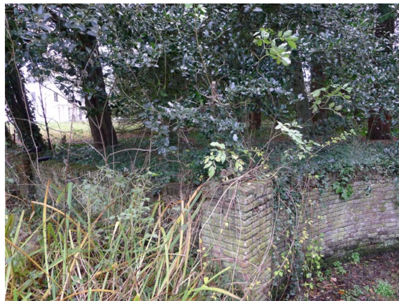
hoek tussen vijver en tuinmuur
