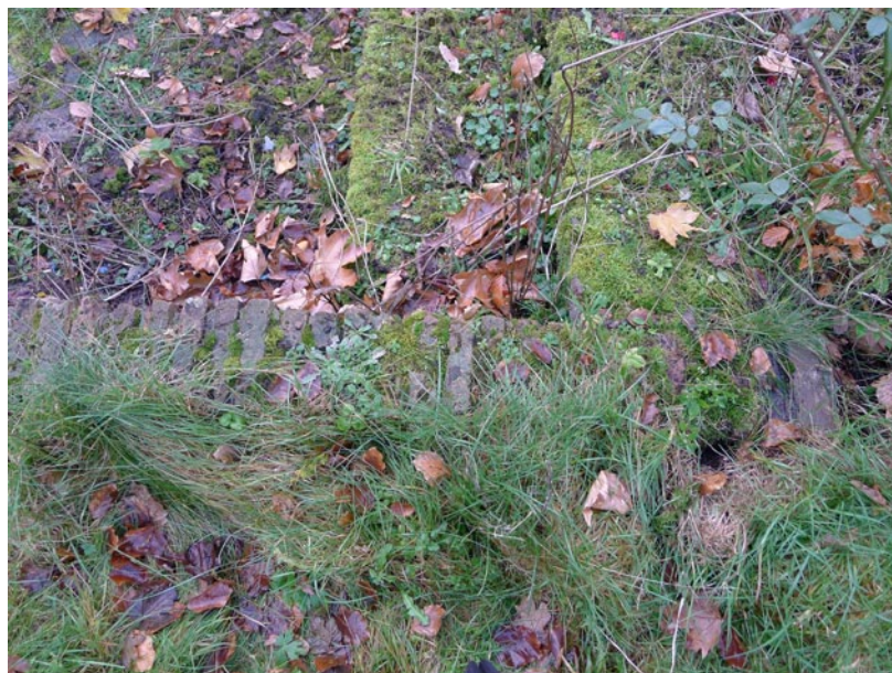
metselwerk bij tuintrap
