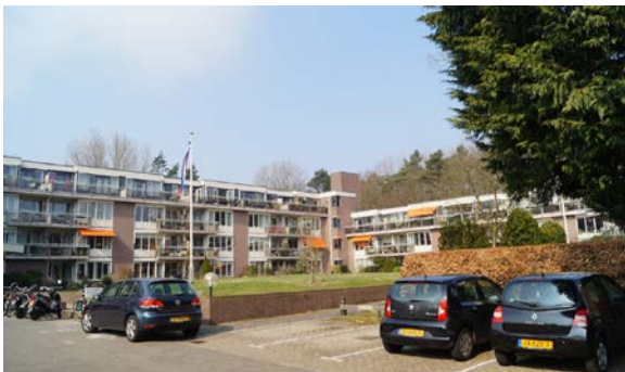
Aanzicht naastgelegen appartementencomplex
