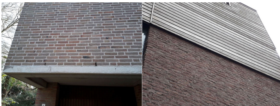
Figuur 4.1 Links spouwgangen die vleermuizen mogelijk toegang bieden tot Euphrasia, rechts kunnen vleermuizen onder het hout het gebouw mogelijk binnenkomen.
