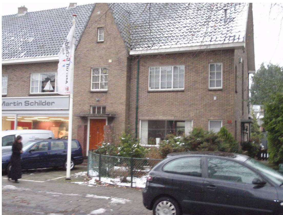
Foto 3, voorzijde onderzoekslocatie (zuidelijke richting)
