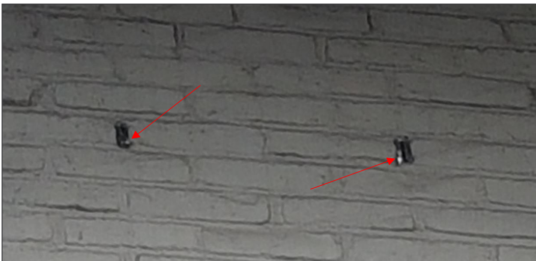
Figuur 9. Geplaatste bijenbekjes (zilver verkleuring op foto) in open stootvoeg.
