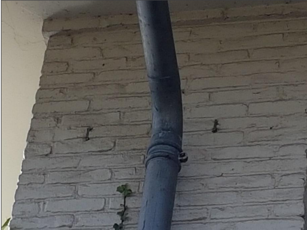
Figuur 7. Aanwezige stootvoegen
