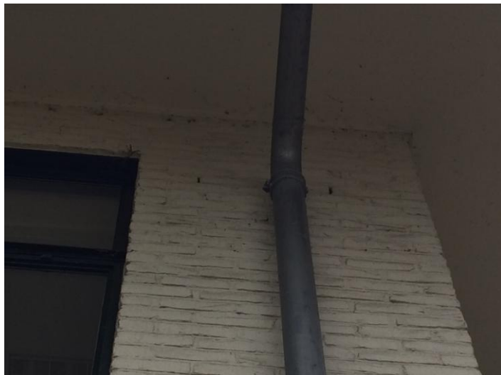
Afbeelding 5.3 De open stootvoegen van het gebouw bieden toegang tot potentieel geschikte verblijfplaatsen in de spouwmuur voor de gebouwbewonende vleermuizen
