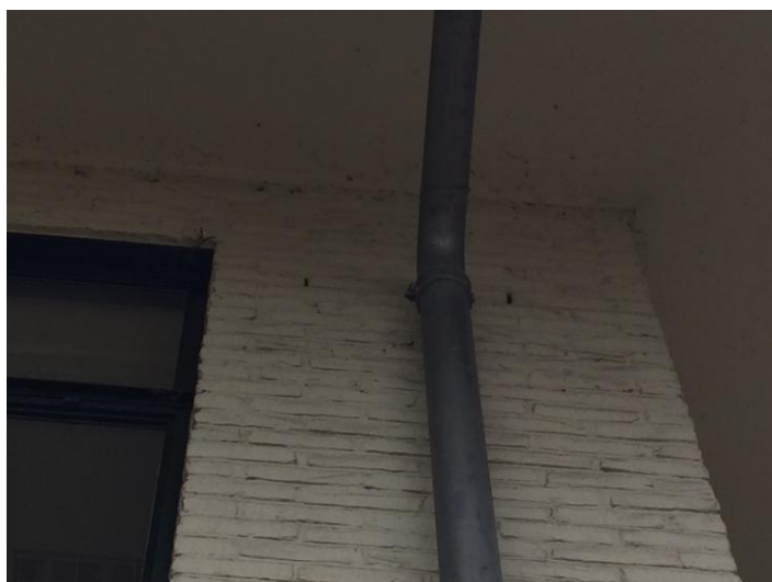
Afbeelding 4.2 De open stootvoegen van het gebouw bieden toegang tot potentieel geschikte verblijfplaatsen voor de meervleermuis in de spouwmuur
