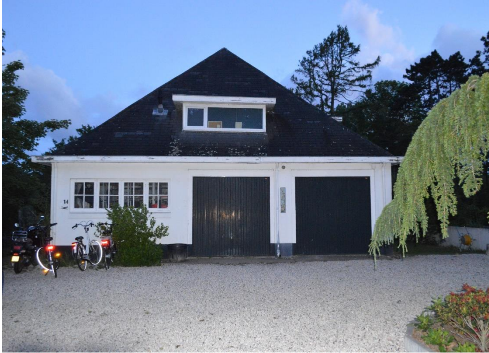
Figuur 3. Voorzijde van de te onderzoeken woning.
