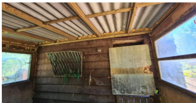
Figuur 8: Binnenkant aanbouw
