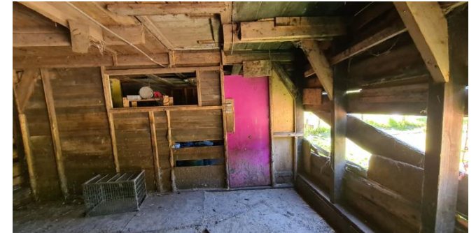
Figuur 5: Binnenkant te slopen schuur
