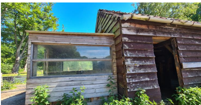
Figuur 7: Aanbouw bij schuur
