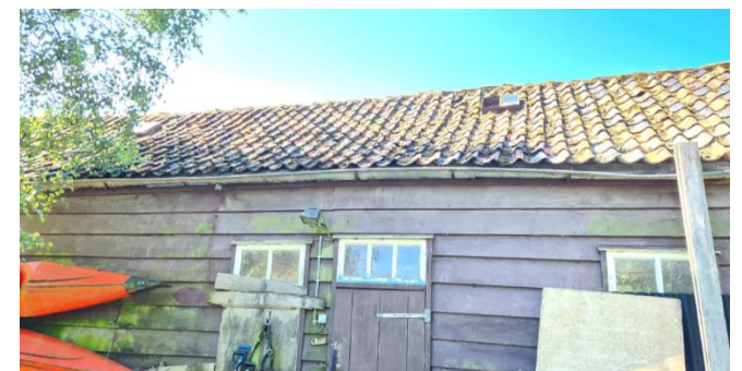
Figuur 9: Noordkant te slopen schuur
