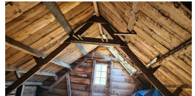
Figuur 6: Zolder te slopen schuur
