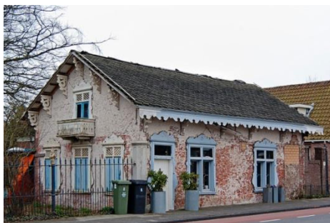
Dienstgebouw Huis te Bennebroek, provinciaal monument aan de Binnenweg 8
