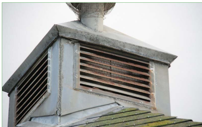
Achter het rooster boven op het dak van de snackbar zit gaas.
