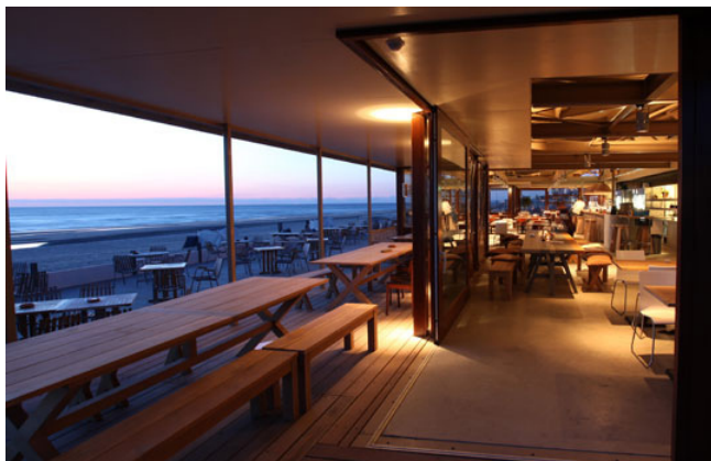
transparant aan de zeezijde (architect BINT)
