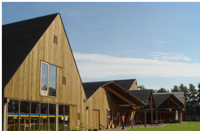
samengestelde kappen, natuurlijke materialen (Onix architecten)
