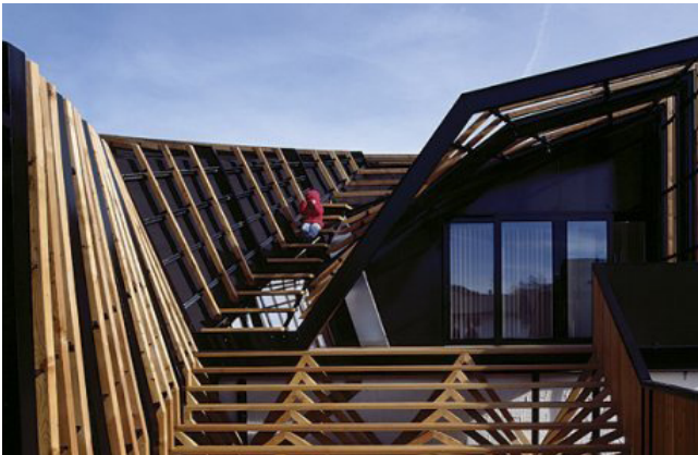
rastwerk maakt vorm en samengestelde kappen
