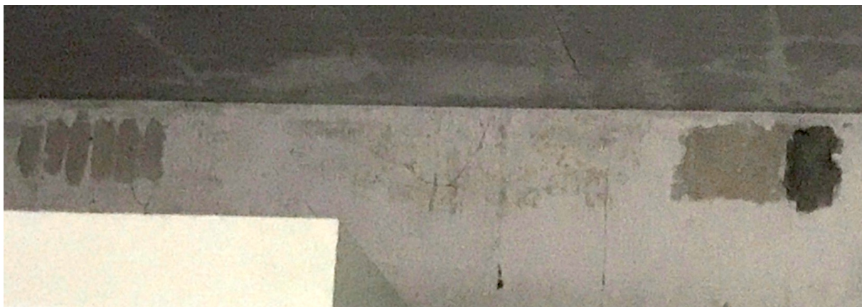
Afgedichte ventilatie openingen binnenzijde
