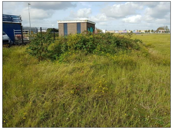
Figuur 8. Transformatorhuisje noordoostelijk perceel
