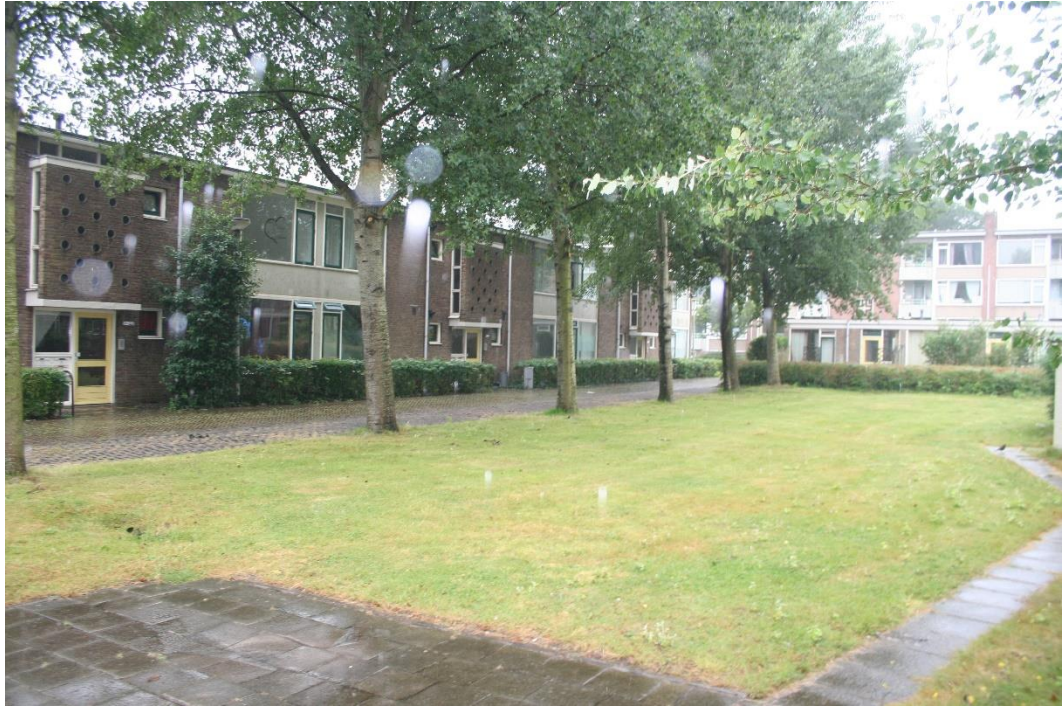
In de gebouwen zijn Invliegopeningen aanwezig
