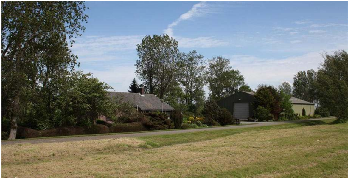
Figuur 9: Foto bestaande situatie
