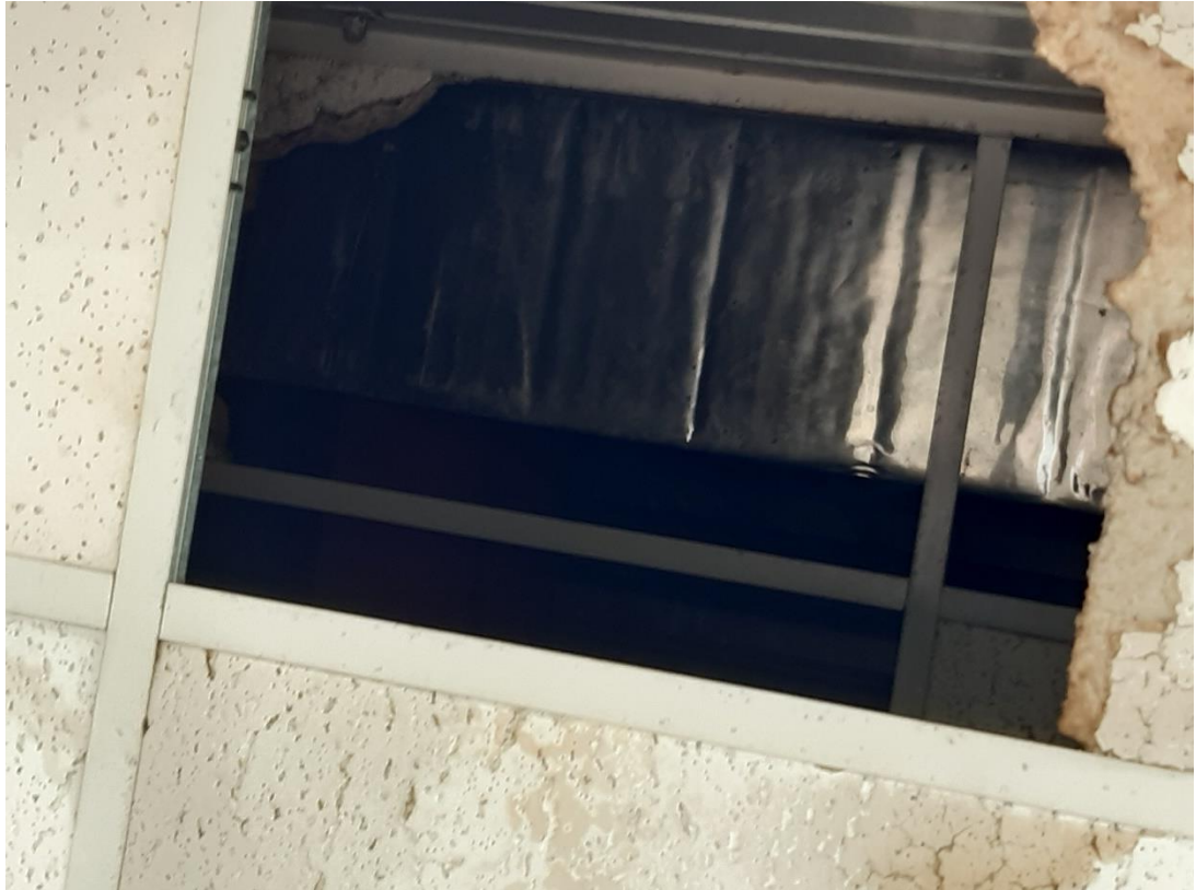
Beeld van onderzijde van het platte dak.
