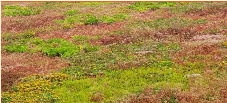
Figuur 1-7: Dakafwerking onderstation.
