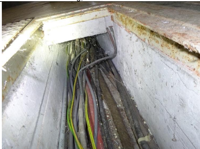
Foto 9: Aanzicht kabelgoot, geen asbestverdachte toepassingen aangetroffen
