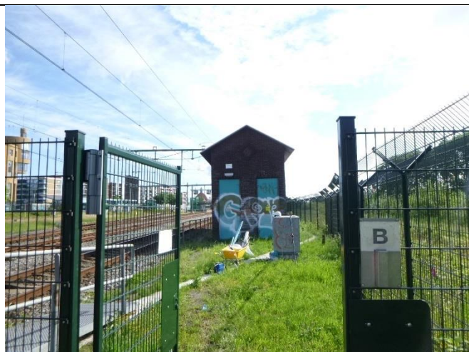
Foto 8: Aanzicht schakelstation vanaf toegangshek
