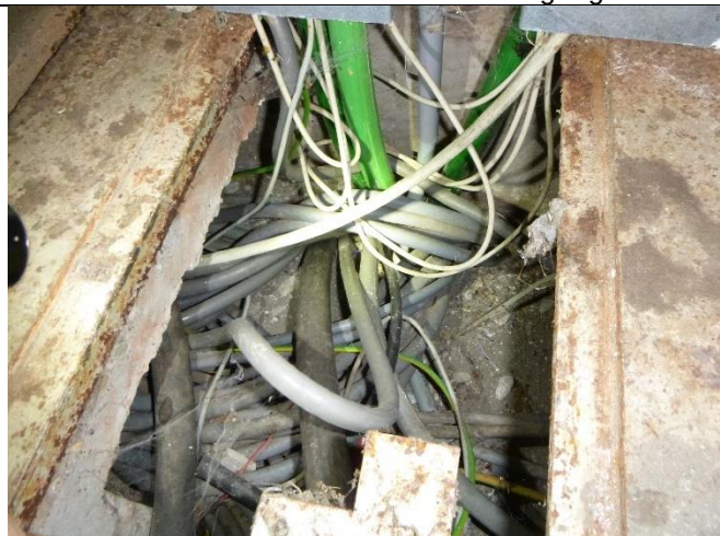
Foto 10: Aanzicht kabelgoot, geen asbestverdachte toepassingen aangetroffen
