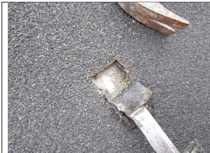
Foto 7: Dakbedekking, niet asbestverdacht
