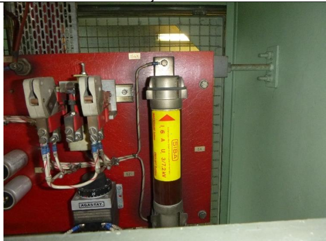
Foto 4: Buispatroon, niet asbestverdacht
