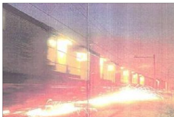
Figuur 2: Het bijlijpen van spoorstaven
