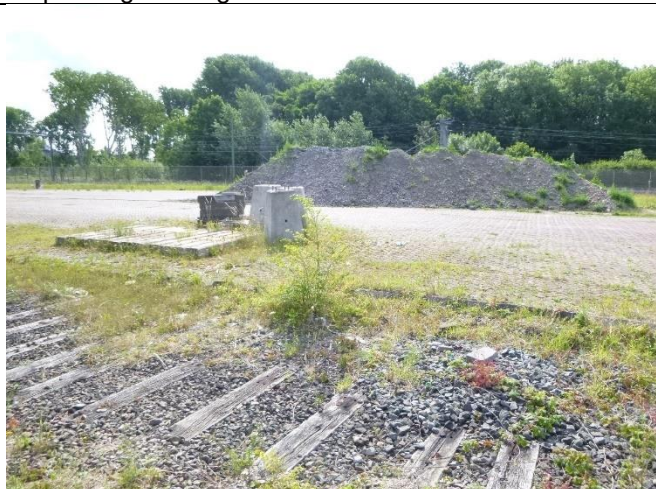
Foto 11: Emplacementsterrein, geen asbestverdachte toepassingen aangetroffen
