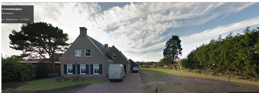
afb. 3 De planlocatie 173 a naast het nieuwe woonhuis Creutzberglaan 173
