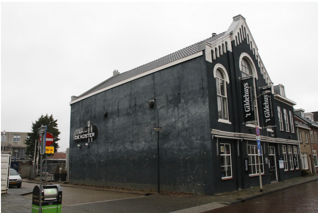
De zuidgevel van het pand. Aan deze zijde zullen er werkzaamheden plaats vinden aan de gevel en aan het dak. Foto: K. de Vries / Ecoresult BV
