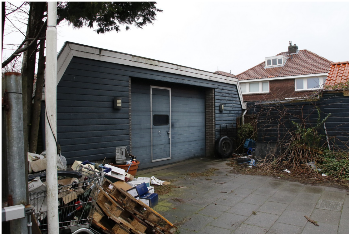
De garage op het achterterrein. Deze garage wordt omgebouwd tot 8 bergingen. Foto: K. de Vries / Ecoresult BV
