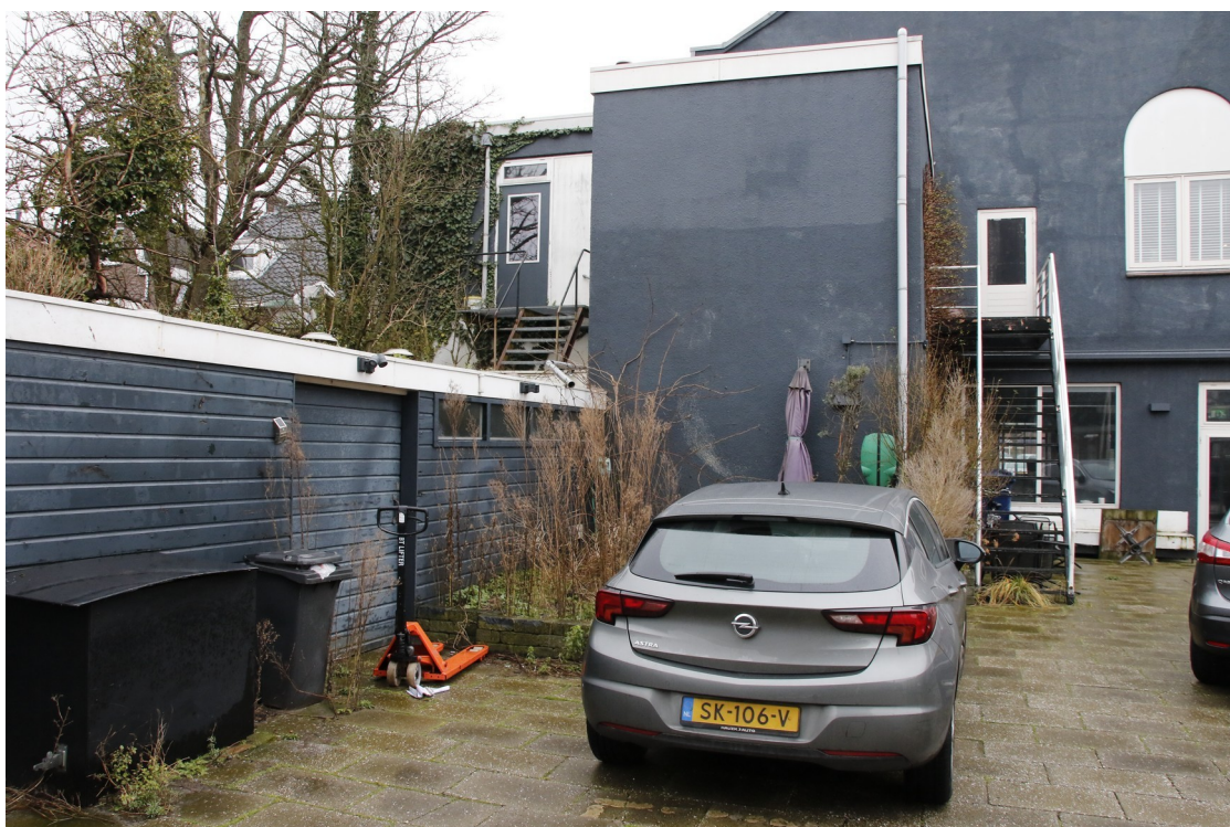
De achterzijde van het pand met de uitbouw, de metalen trap en houten schuren. Ook is het aanwezige groen zichtbaar. Foto: K. de Vries | Ecoresult BV
