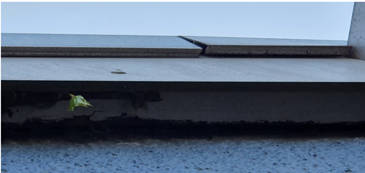
De onderzijde van de dakgoot van de nader geïnspecteerde gevel. Hier zijn geen gaten en kieren aanwezig. Foto. K. de Vries | Ecoresult BV
