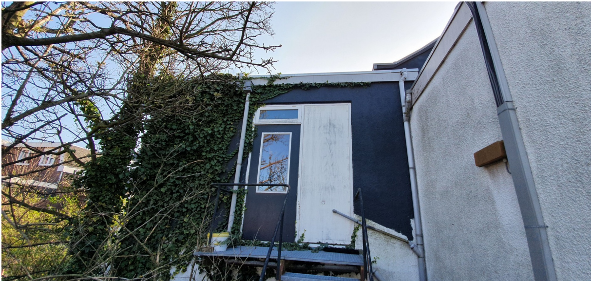
De noordwestelijke gevel die op 02-04-2020 nader geïnspecteerd is. Foto. K. de Vries | Ecoresult BV
