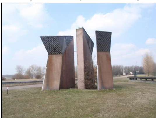
Afbeelding 7: Kunstwerk op het dak van de Wijkertunnel.
