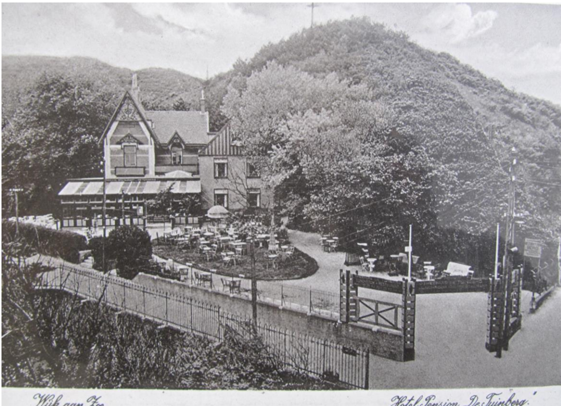
W. van Lee Hotel Pension De Tuinberg aan de Van Ogtropweg rond 1910
