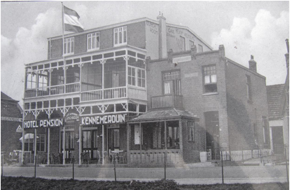
Hotel Pension Kennemerduin langs de Verlengde Voorstraat
