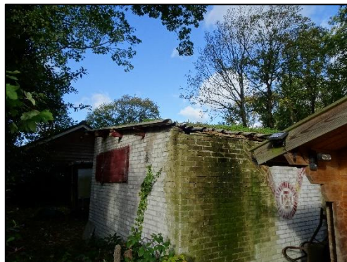
Aanzicht oostelijke zijde te slopen schuur
