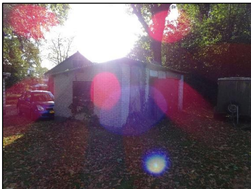
Aanzicht westelijke zijde te slopen schuur
