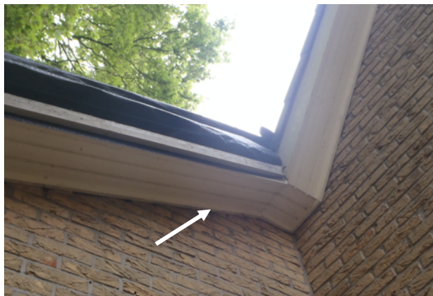
Afbeelding 14. De muren hebben onder de daklijsten kleine openingen die groot genoeg zijn voor vleermuizen
