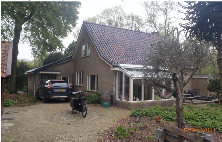
Afbeelding 17. Zicht op de locatie waar sloop en nieuwbouw plaatsvindt
