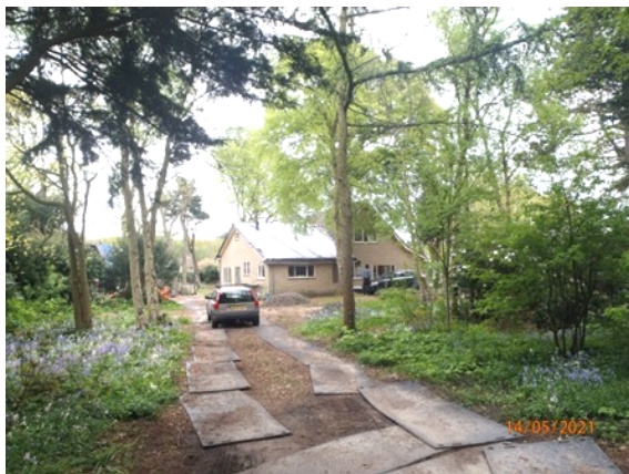
Afbeelding 7. Huismansweg 10 gezien vanaf de weg
