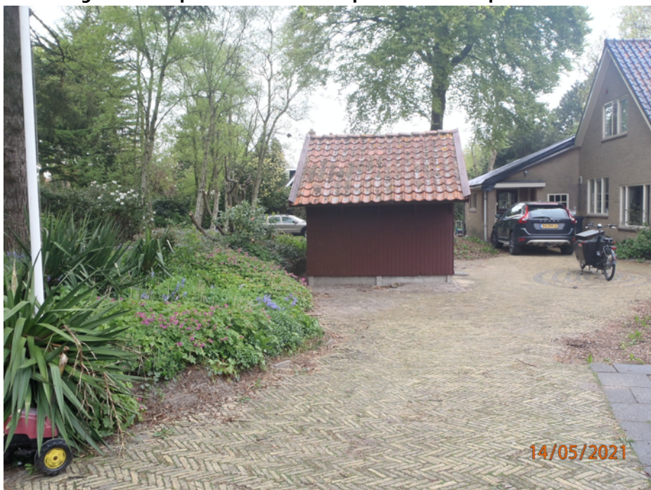
Afbeelding 18. Zicht op de locatie waar sloop en nieuwbouw plaatsvindt
