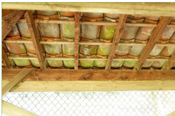
Dakpannen zonder betimmering op het lage afdak.
